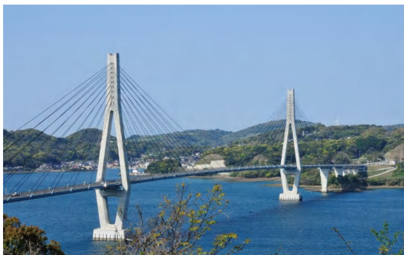
鷹島肥前大橋(佐賀県唐津市)
